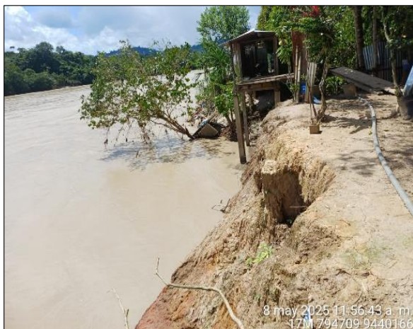
IMAGEN 01: SE MUESTRA EL ESTADO ACTUAL DE LA MARGEN DERECHA DEL RIO MARAÑÓN CON EROSION EN EL BORDO
